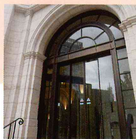
名古屋商科大学では出入り口の枠や扉に硫化いぶし仕上げが施されている。
