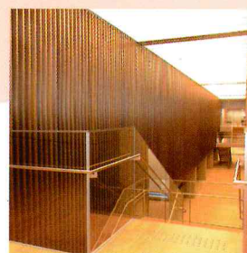
京都国立博物館では内装壁とルーバー金物が硫化いぶし仕上げになっている。
